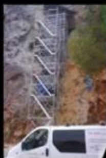
Montaje de andamio multidireccional en una excavación arqueológica. (CASTELLDEFELS)
