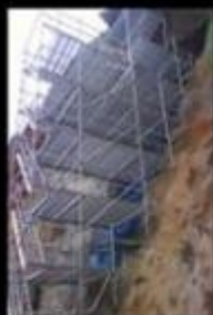
Montaje de andamio multidireccional en una excavación arqueológica. (CASTELLDEFELS)
