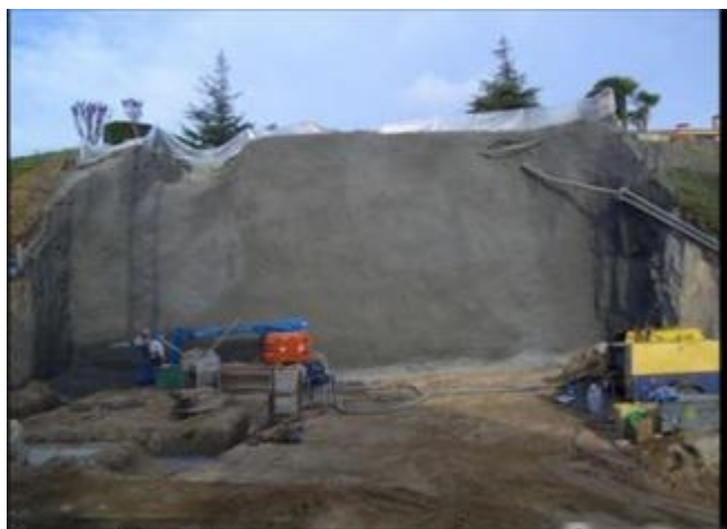
Aplicación de hormigón proyectado (gunita).
