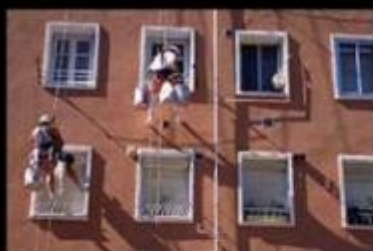
Aplicación de hormigón proyectado (gunita).
